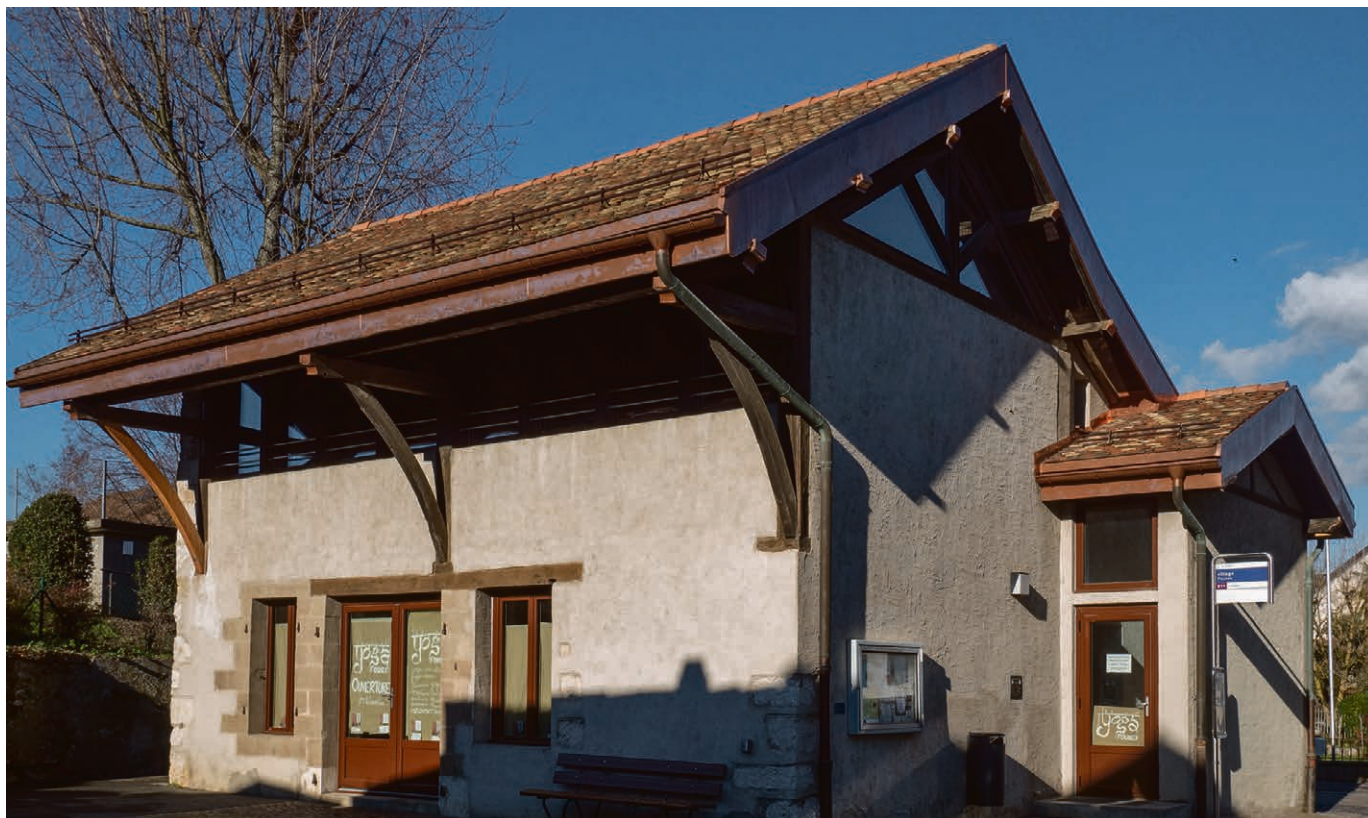
La Maison de paroisse de Founex, remise à neuf. © A. Sublet.
